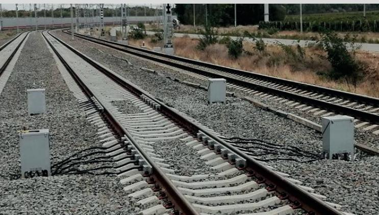
СЖДК используется для взвешивания вагонов на транспортных магистралях, товарных станциях, в портах, карьерах, таможенных терминалах и предприятиях, осуществляющих интенсивную перевалку грузов.
