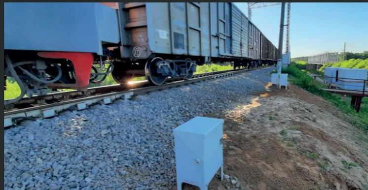
СЖДК предназначена для автоматического весового и логистического контроля поездов в движении с целью обеспечения безопасности движения, контроля сохранности грузов в пути следования и выявления единиц подвижного состава с нарушением установленных норм загрузки.
